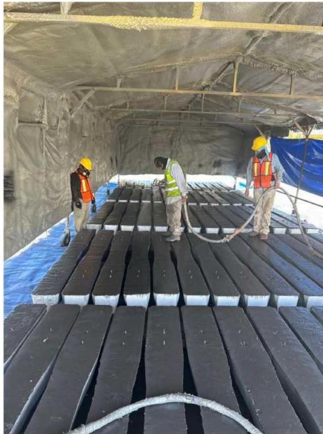
Figura 9. Aplicación de poliuretano esprayado en sitio para la conformación de suelas bajo durmiente.
